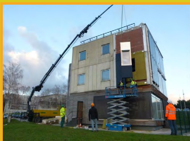
Sistema industrializado Plug&Play de rehabilitación de fachadas (imágenes cedidas por TECNALIA)
